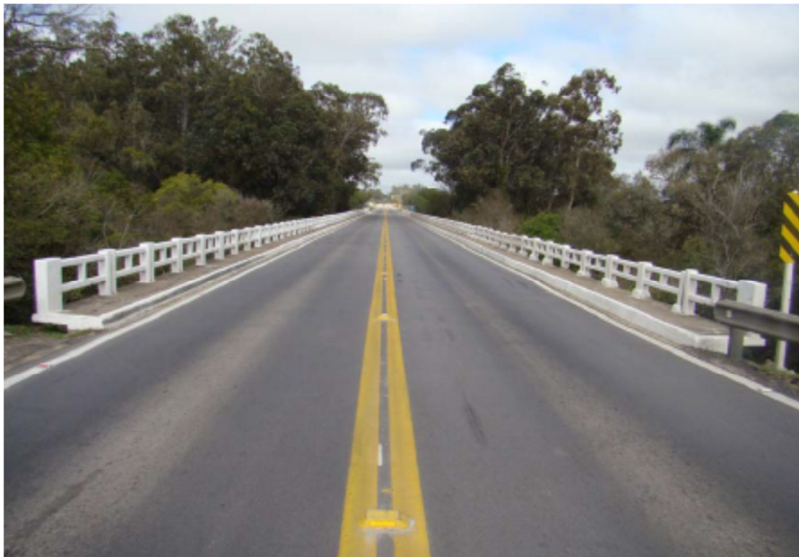
Foto 01 – Vista geral da obra
