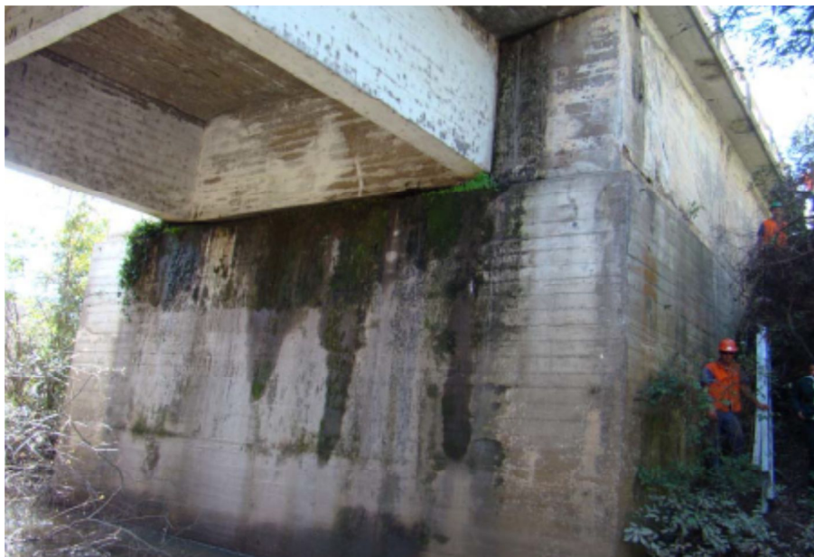
Foto 06 – Detalhe encontro – Lado Camaquã
