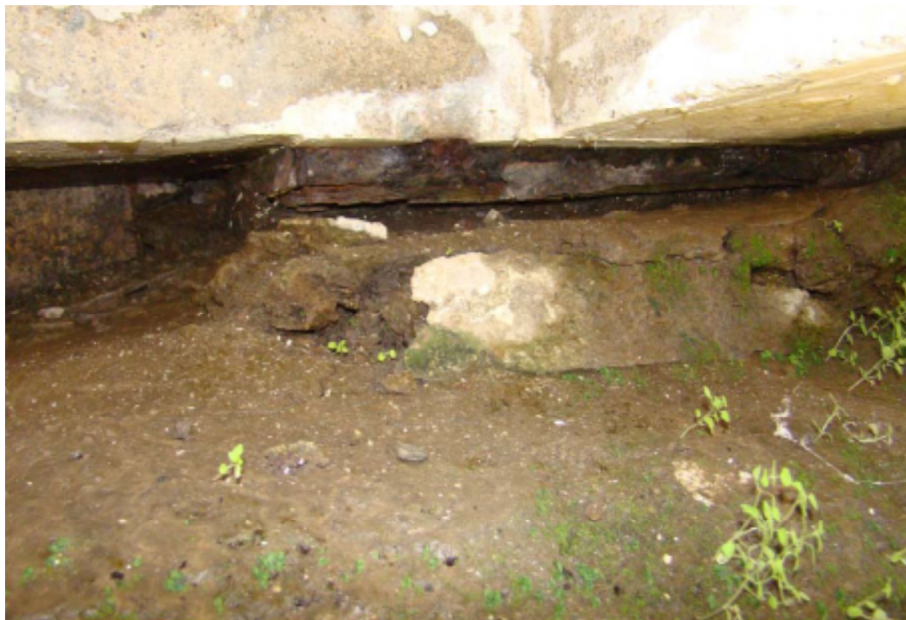
Foto 12 – Detalhe aparelho de apoio – Lado Camaquã
