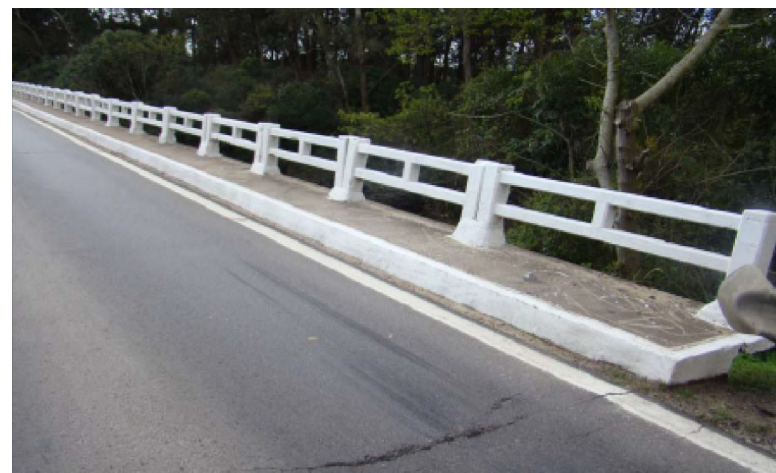
GUARDA CORPO FIXADO DE FORMA INADEQUADA - LADO PELOTAS
