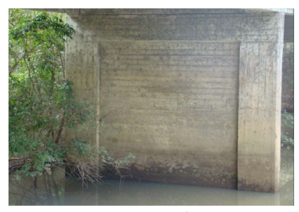
PILAR CORTINA EM BOAS CONDIÇÕES
