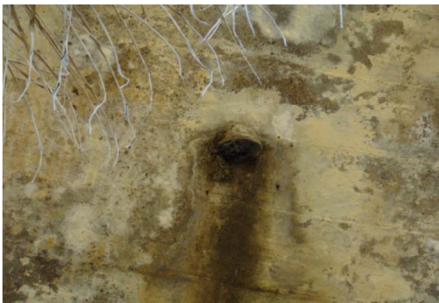
Foto 23 – Dreno pluvial vista inferior
