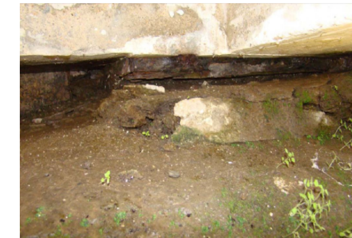
APARELHO DE APOIO OBSTRUIDO E CORROSÃO DAS CHAPAS - LADO ESQUERDO CAMAQUÃ
