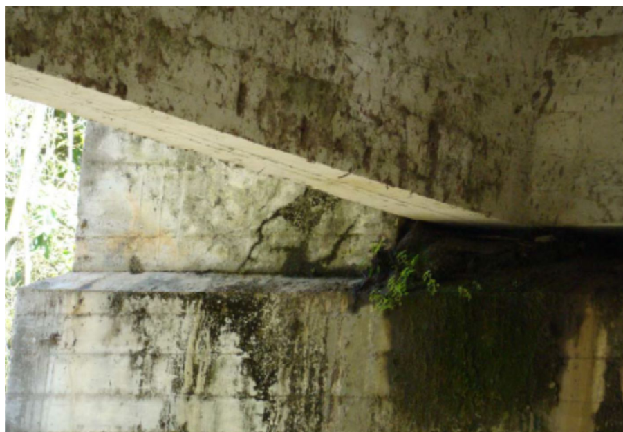
Foto 13 – Detalhe aparelho de apoio – Lado Pelotas
