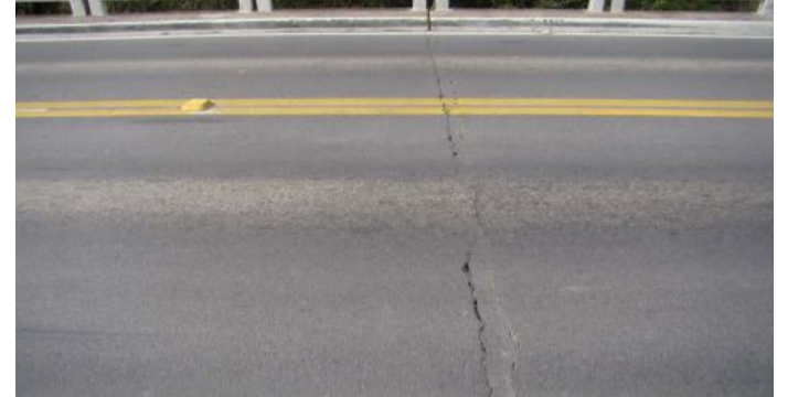
JUNTA DE DILATAÇÃO OBSTRUIDA
