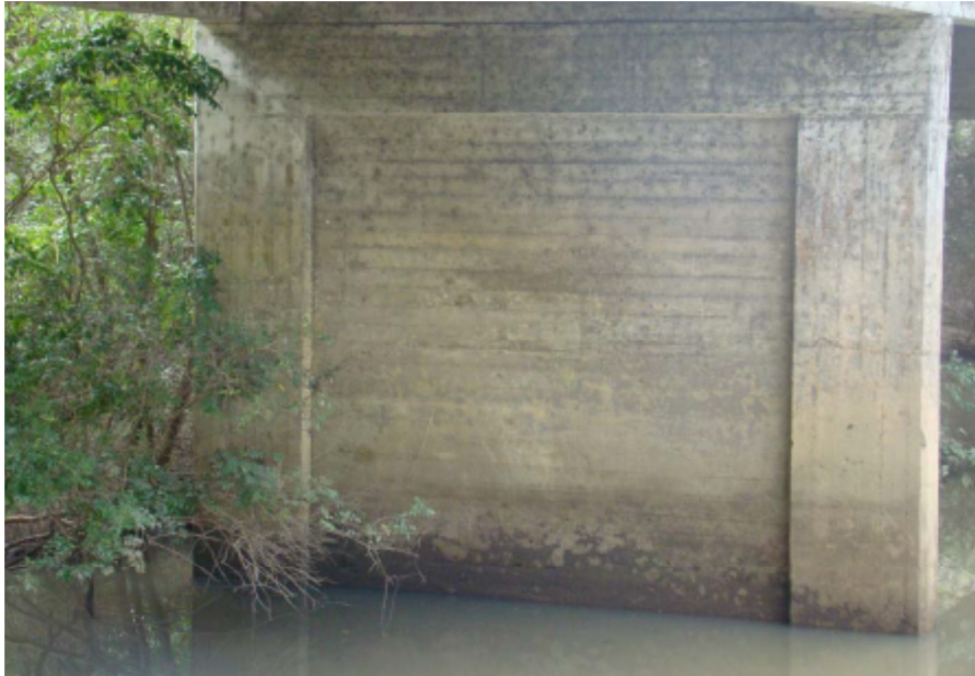
Foto 04 – Apoio P8 – pilar cortina
