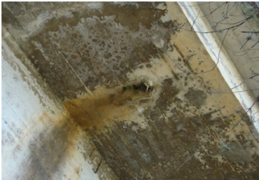
Foto 24 – Dreno pluvial vista inferior
