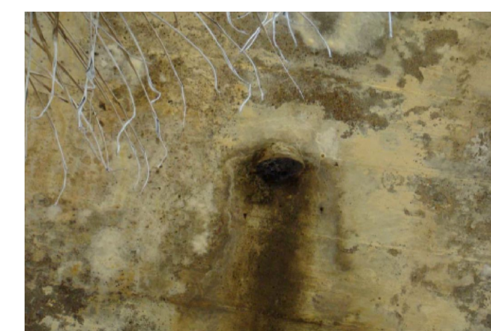
DETALHE DE DRENO PLUVIAL CURTO
