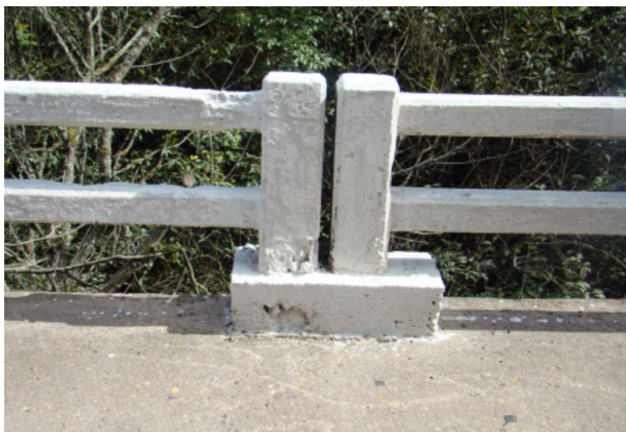
Foto 29 – Detalhe fixação do Guarda Corpo
