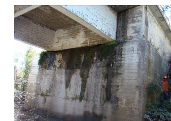
VISTA GERAL DO ENCONTRO LADO CAMAQUÃ
