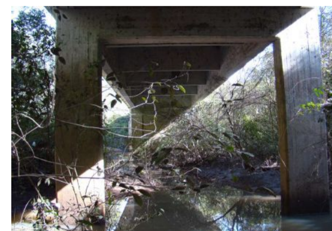
PORTICO EM BOAS CONDIÇÕES - P7 LADO PELOTAS
