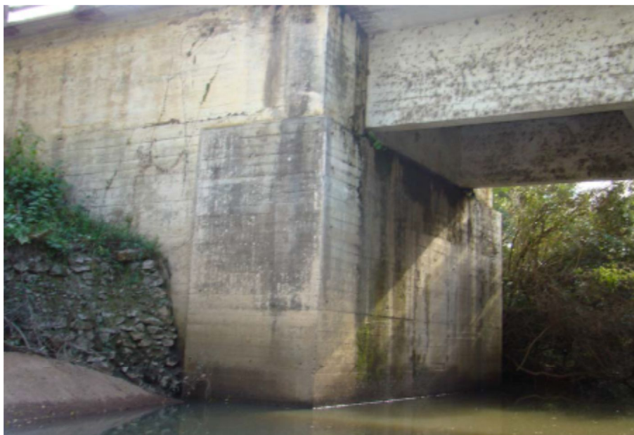
Foto 09 – Detalhe encontro – Lado Pelotas
